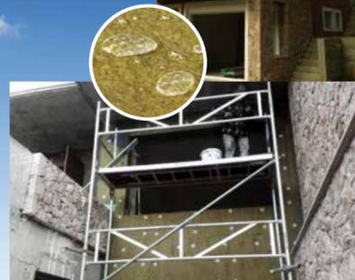
Pannelli in lana di roccia FIBRANgeo BP-ETICS & FIBRANgeo BP-ETICS PLUS traspiranti e aventi una resistenza al vapore acqueo pari a  $\mu = 1$  - che contribuisce allo smaltimento attraverso la parete dell'umidità e delle sostanze inquinanti contenute nell'ambiente interno, migliorando il comfort e garantendo caldo d'inverno e il fresco d'estate.
