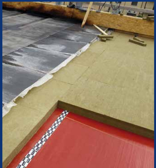
Coperture piane occasionalmente pedonabili su solaio con FIBRANgeo BP-50 BIT
