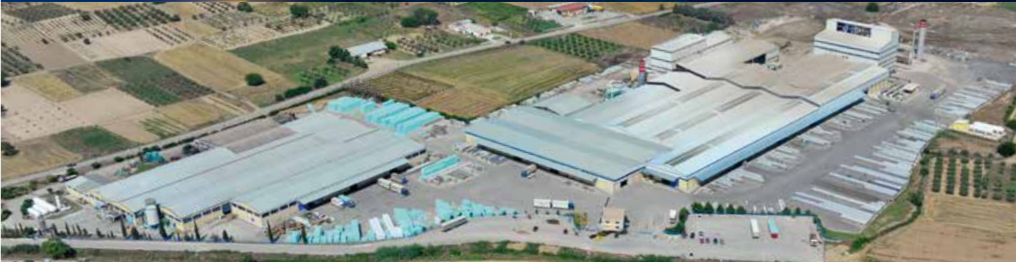
Stabilimento di produzione di lana di roccia a Terpni (Grecia)
