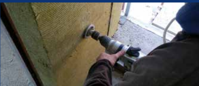
Pareti perimetrali con isolamento a cappotto con FIBRANgeo BP-ETICS e dischi isolanti FIBRANgeo CAP installati dopo la fresatura con FIBRANtools FREZA .
